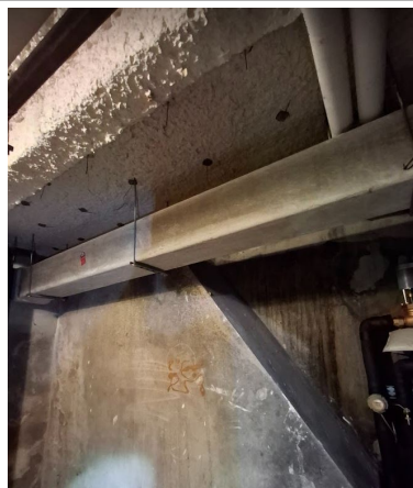
prélevé - idem P065 : R-1 / Sous-station chauffage - Conduit- (Présence d'amiante)
