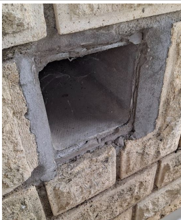
Prélèvement - P092 : RDC / Cour patient est - Conduit- (Présence d'amiante)
